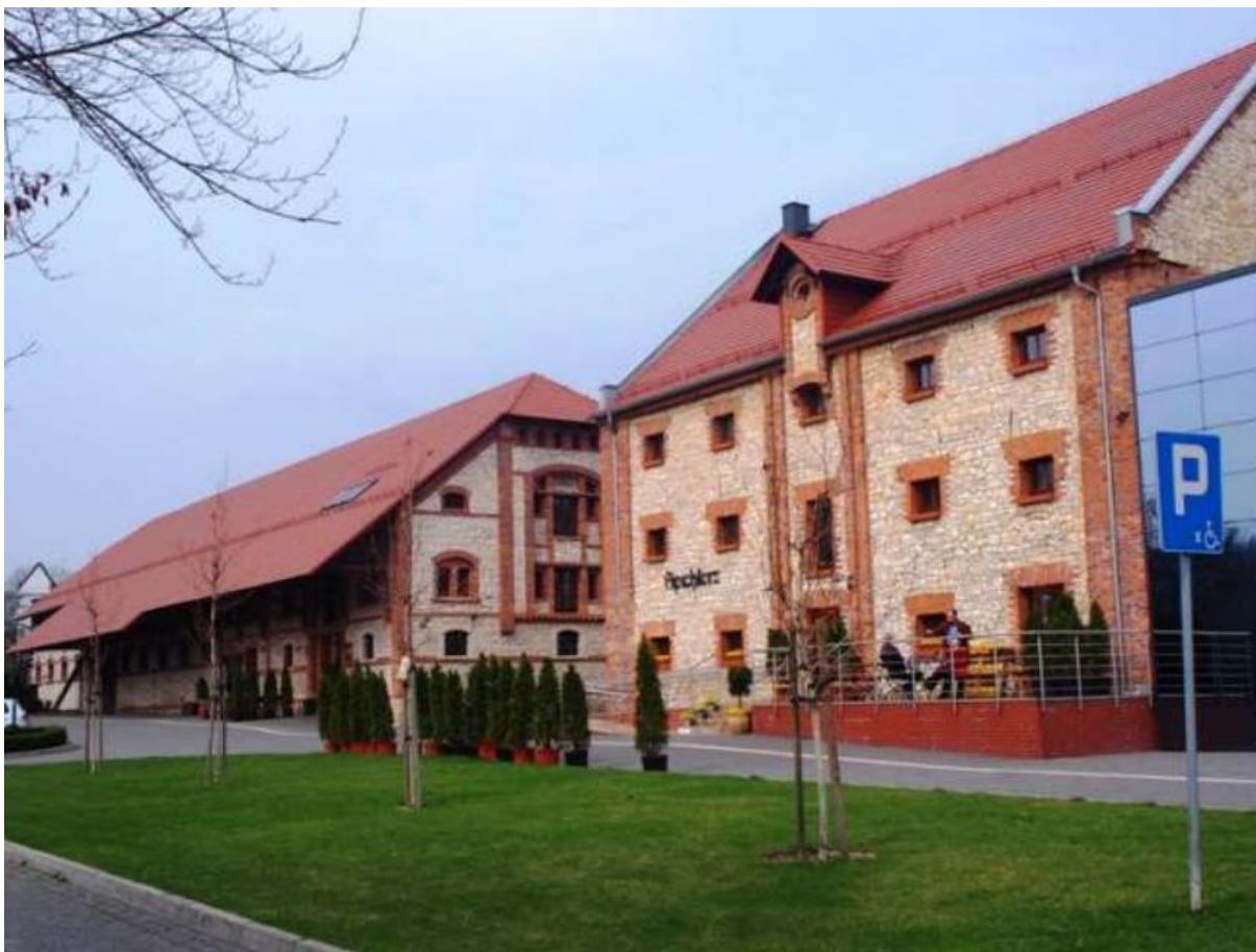
Fot. 3. Olszowa, budynki folwarczne, ul. Hodowlana (fot. materiały Gminy Ujazd).
